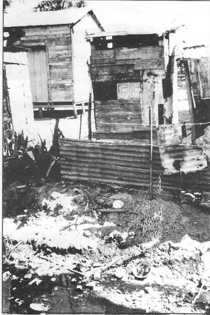
23. Letrina que descarga en una quebrada [Latrine discharging onto a stream].
