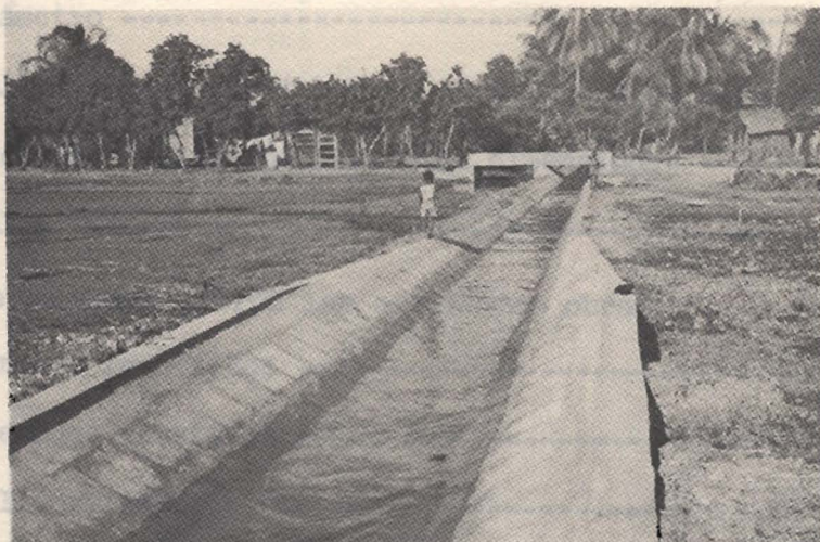
Instalación de 2 compuertas automáticas
