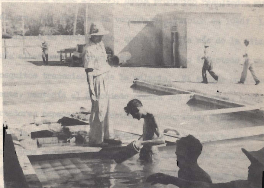
Curando tubería de drenajes
