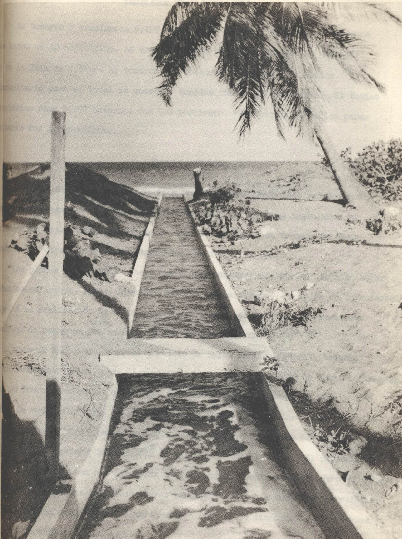
Canal de descarga de una bomba
